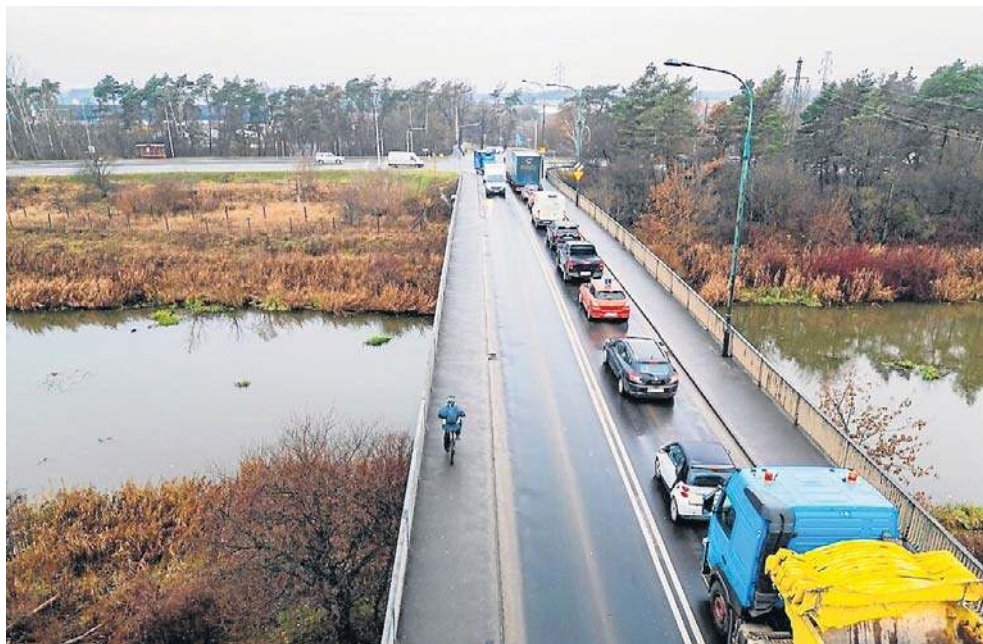
Zostanie przebudowany most spinający brzegi Kanału Żerańskiego na Białołęce. Nowy - podobnie jak obecny - będzie miał po jednym pasie ruchu w każdą stronę
