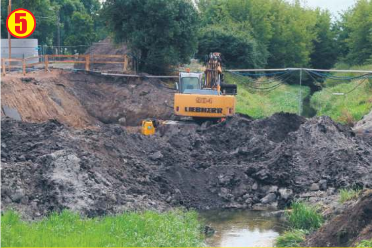
Nieco szybciej, bo do końca listopada mają potrwać utrudnienia na ulicy Pawiej (między Kunickiego a Wspólną). Ulica jest przebudowywana, a stary most na Czerniejówce zostanie zastąpiony nowym, którego konstrukcja już została postawiona.
