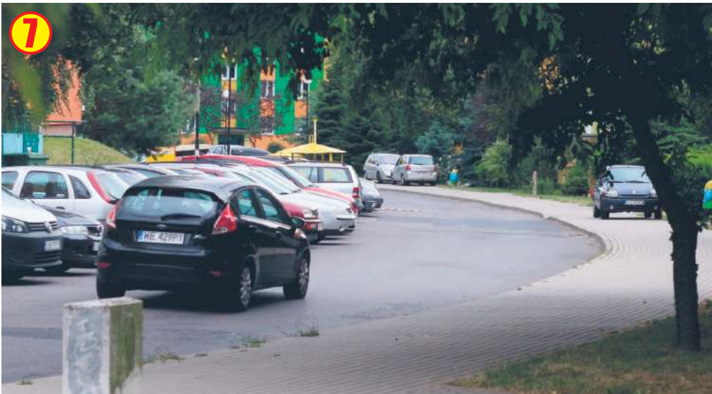
Drogowców lada dzień spotkamy również na ulicy Kaczeńcowej, gdzie Komunalne Przedsiębiorstwo Robót Drogowych z Lublina będzie przebudowywać całą osiedlową ulicę. Wykonawca ma obowiązek zapewnić jej przejeźdźność przez cały czas remontu, który ma potrwać do 30 października, ale korkowania się ulicy w szczycie zapewne nie da się uniknąć.
