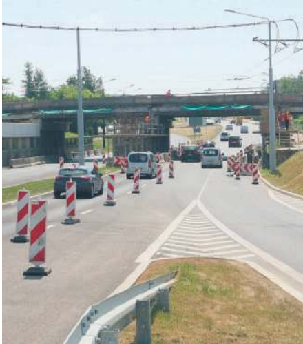
Ważną rolę w budowie mają również ul. Kroczyńska, ul. Kroczyńska II, Kroczyńska III i Kroczyńska IV. Co prawda prace polegają na budowie tego skrzyżowania z ul. Kroczyńską, ale na zjeździe z wiaduktu na ul. Kroczyńską jest z ruchu jeden pas jezdni z powodu remontu znajdującego się tam wiaduktu kolejowego.
