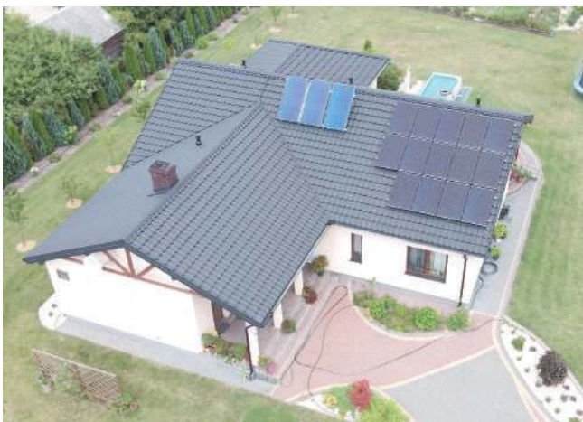
Zakończył się już montaż instalacji fotowoltaicznych
