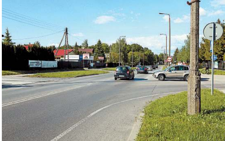
Na budowę ronda i fragmentu ulicy Rejkowizna wraz z infrastrukturą towarzyszącą wykonał, którym jest Przedsiębiorstwo Robót Drogowych Lubartów S.A., ma czas do końca listopada br. Inwestycja pochłonie 1 088 616,91 zł.
