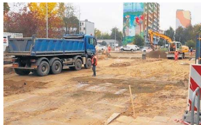
Na budowie ronda u zbiegu ulic Zbrowskiego i Żeromskiego w Radomiu pracuje ciężki sprzęt.
