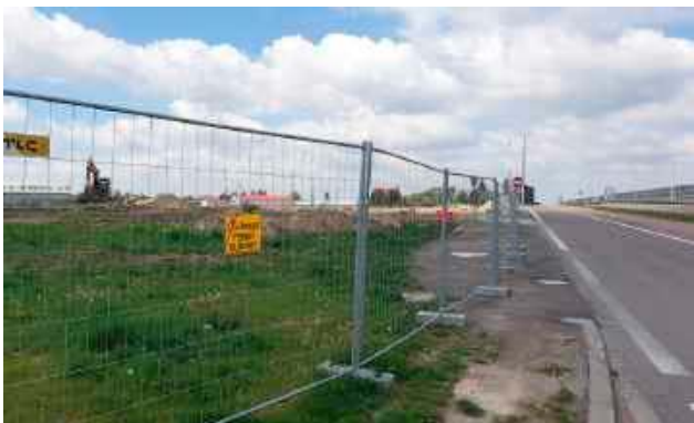
Po starej stacji tankowania w Wierchowiskach nie ma już śladu. Ruszyły prace nad budową MOP
