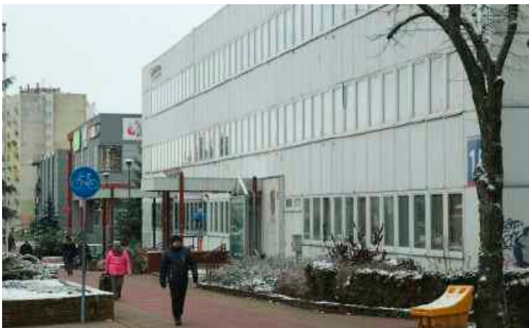
Charakterystyczny „blaszak”, w którym przez kilkadziesiąt lat miał swoją siedzibę urząd miasta, zapewne przez nowego właściciela nieruchomości zostanie rozebrany
