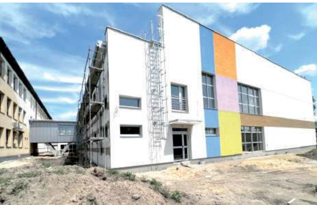
Budowa nowej hali w Biłgoraju ma zakończyć się w grudniu
