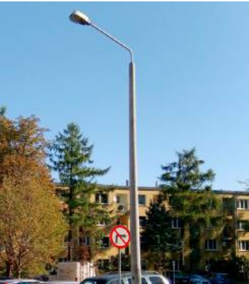
Wymieniona latarnia przy ul. Puławskiej
