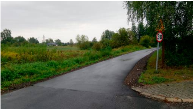
Nowy asfalt na ul. Jarmarcznej
