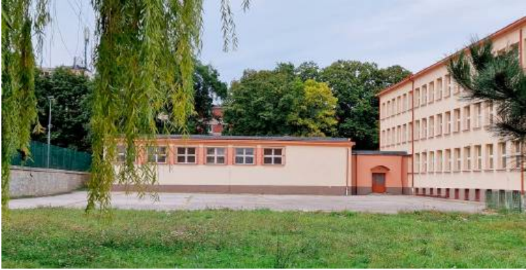
Nowa sala gimnastyczna „Trójki” stanie za dawną „Jedynką”, w miejscu betonowego placu. Stara hala zostanie natomiast przebudowana na jej zaplecze. Znajdą się tu szatnie, toalety, pokój wuefistów i magazyn na sprzęt
