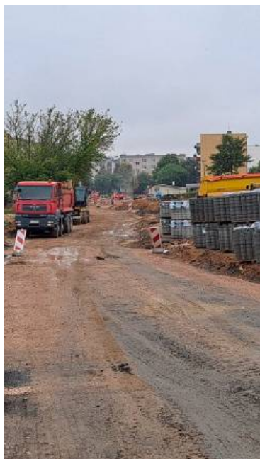
Patrząc na stan zaawansowania prac (tak wyglądały one 9 września), mieszkańcy mają obawy, czy przebudowa zakończy się w październiku
