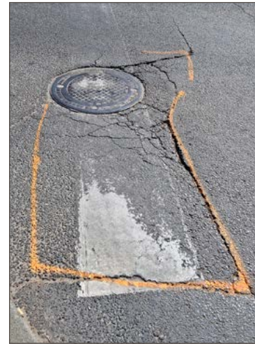
Niebawem zacznie się wycinanie uszkodzonego asfaltu.
