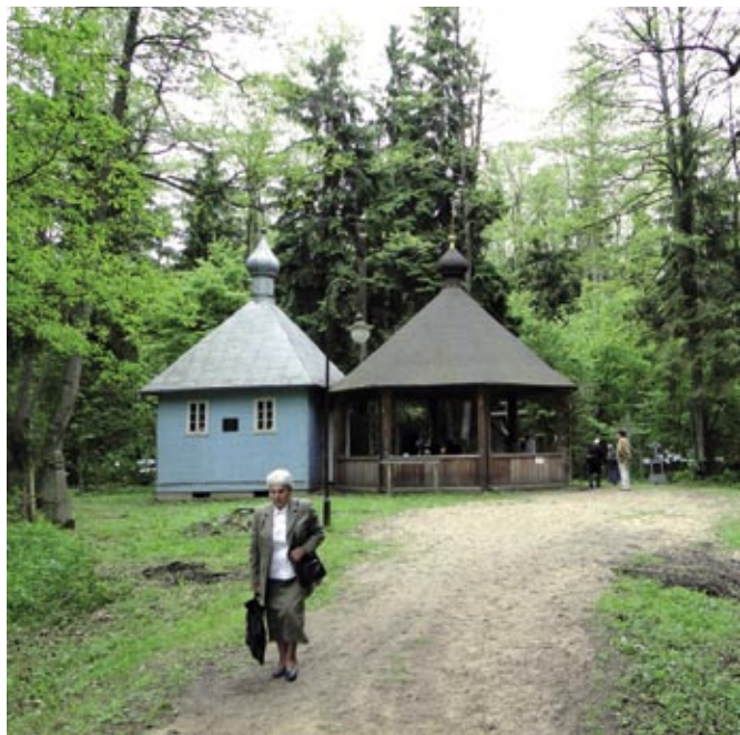
Obecny stan budowli nad źródłem-studnią w uroczysku Krynoczka.
