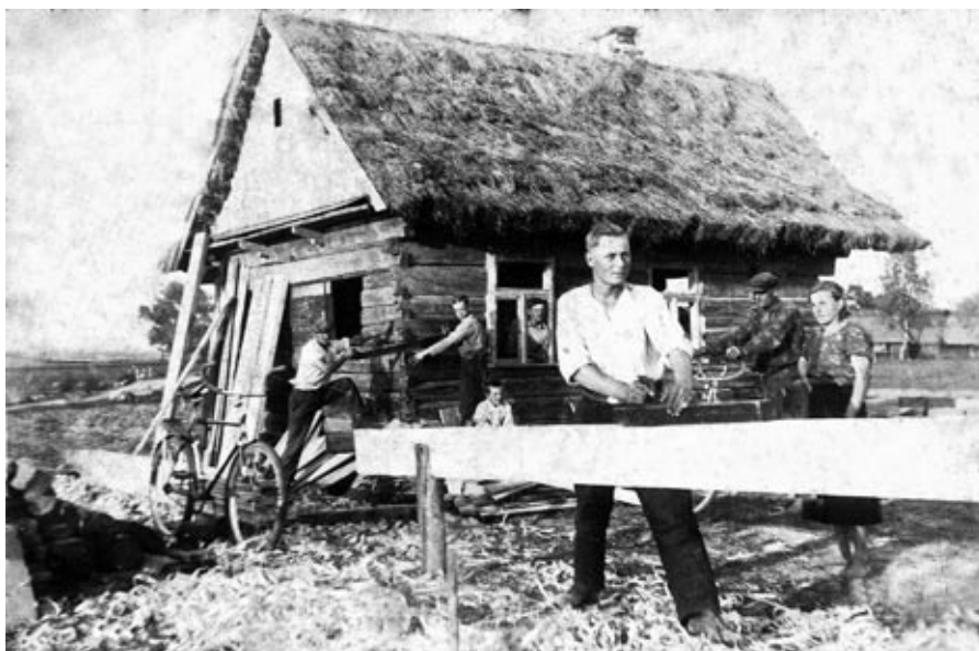
Budowa domu Jaszki Moroza w Szostakowie. Po wkroczeniu Sowieców w 1939 roku Jaszka sprzedał dom i przeprowadził się do Hajnówki.
