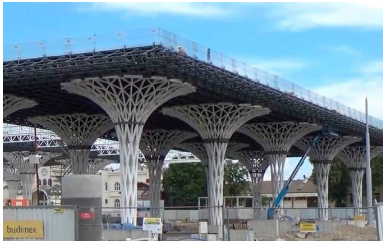
Budowa dworca metropolitalnego będzie droższa o 43 mln zł od zapisanych w pierwszej umowie z wykonawcą 237 mln zł
