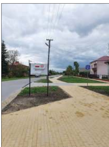
▲ Chodnik i ścieżka rowerowa
