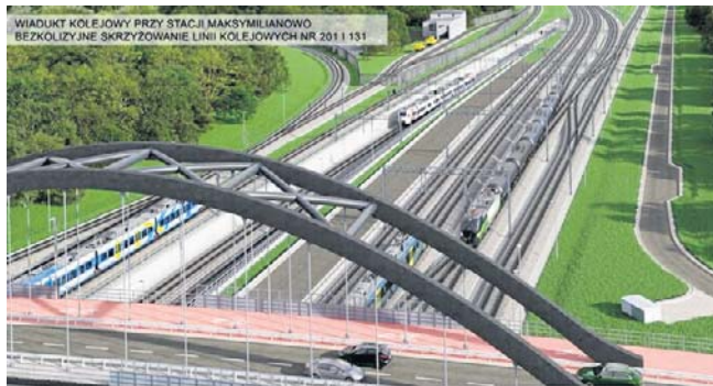
Tak ma wyglądać nowy wiadukt w Maksymilianowie
