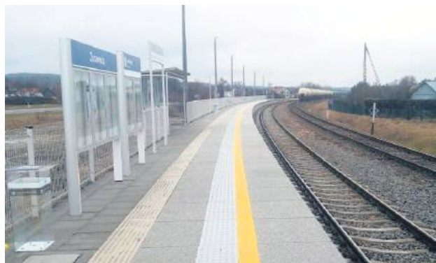
Przystanek w Żurawnicy powstał w ramach „Rządowego programu budowy lub modernizacji przystanków kolejowych na lata 2021-2025”. Fot. PKP Polskie Linie Kolejowe
