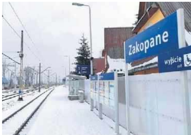
Tymczasowy dworzec kolejowy na Spyrkówce w Zakopanem
