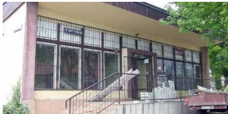
Budynec starej biblioteki przed rozbiórką
