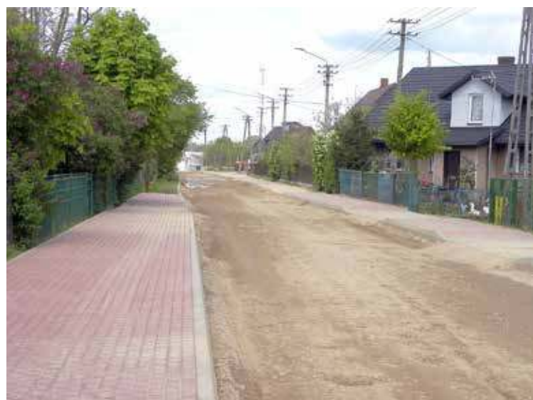
Tak remontowana droga wyglądała w maju.
