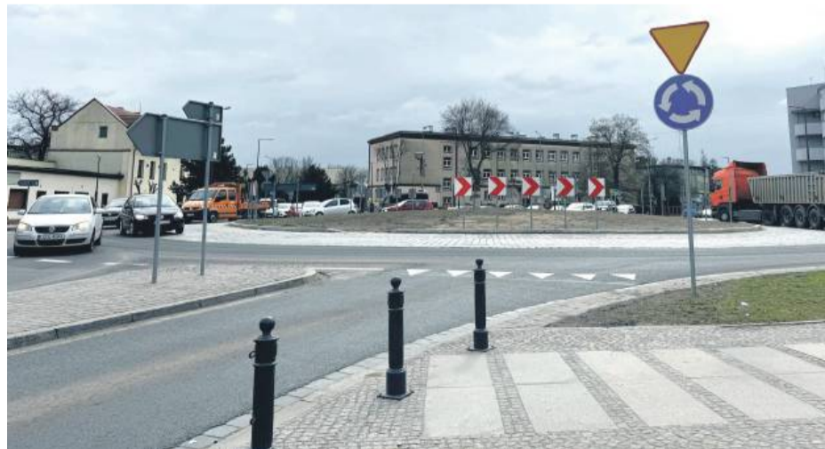
Strzeleńskie rondo po przebudowie
