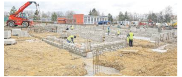
Trwają intensywne prace przy wylewaniu ław i budowie ścian fundamentowych nowego przedszkola. Fot. UMIG Strzelin
