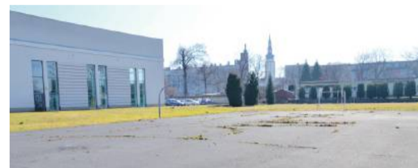
W tym miejscu przy strzelińskim ogólniaku powstanie nowoczesny kompleks boisk
