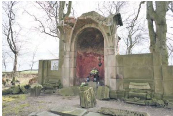
W Wawrzęicach znajduje się neogotyckie mauzoleum, wzniesione w 1907 roku, które kilkanaście lat temu zostało zdewastowane
