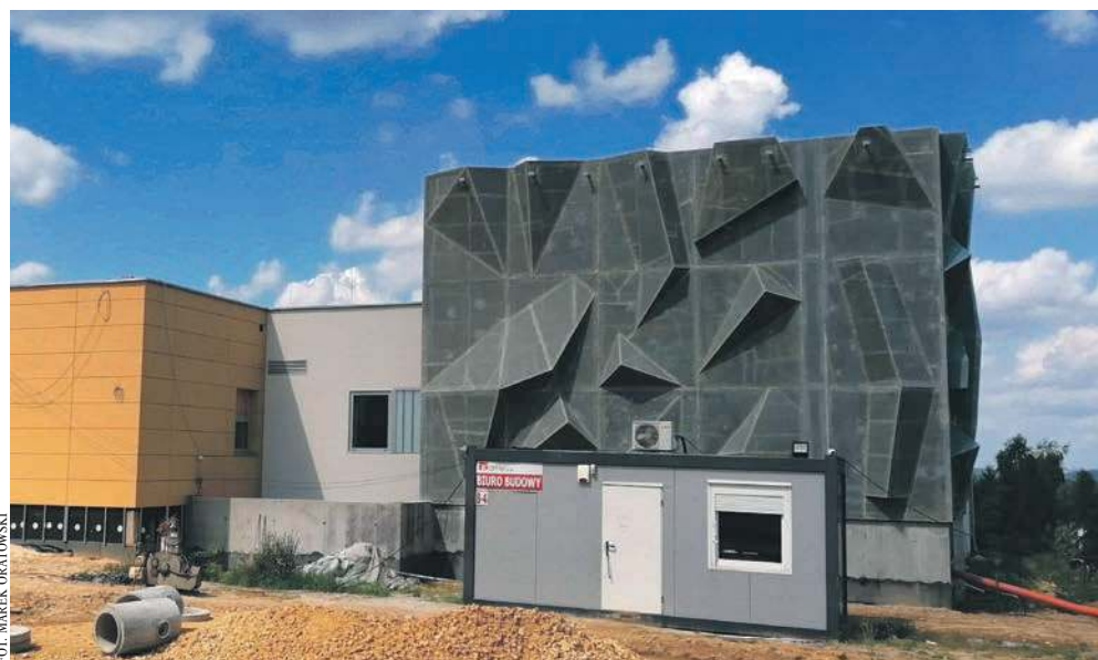
Przy krytej pływalni budowanej na osiedlu Flagówka znajdzie się zewnętrzna ścianka wspinaczkowa. Już można ją oglądać. Zmieni się jeszcze tylko jej kolorystyka
