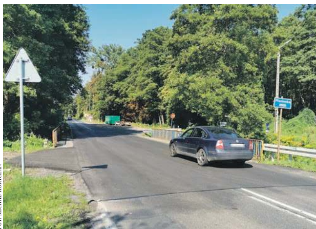
Most na ul. Oświęcimskiej w Wygielzowie
