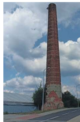
Komin na ul. Ochronkowej
