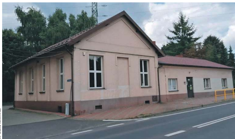
Obiekt jest wyłączony z użytkowania od dwóch lat
