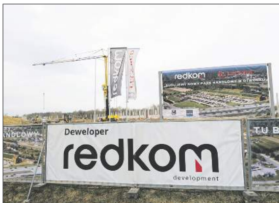
✚ Prace budowlane w parku są już zaawansowane
