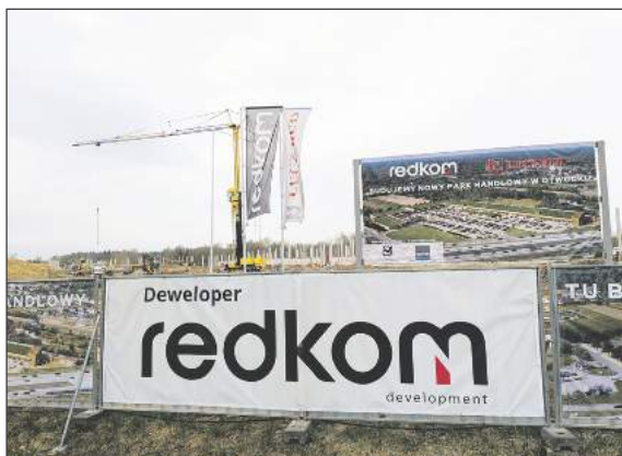
✚ Prace budowlane w parku są już zaawansowane
