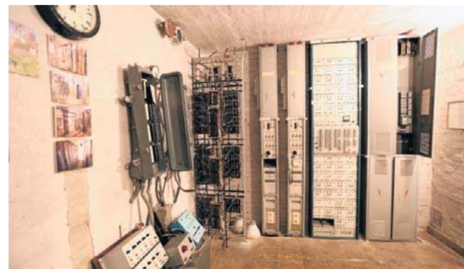
Tak wyglądało wnętrze jednego z pomieszczeń budynku, będącego częścią systemu Rokada w Baczynie
