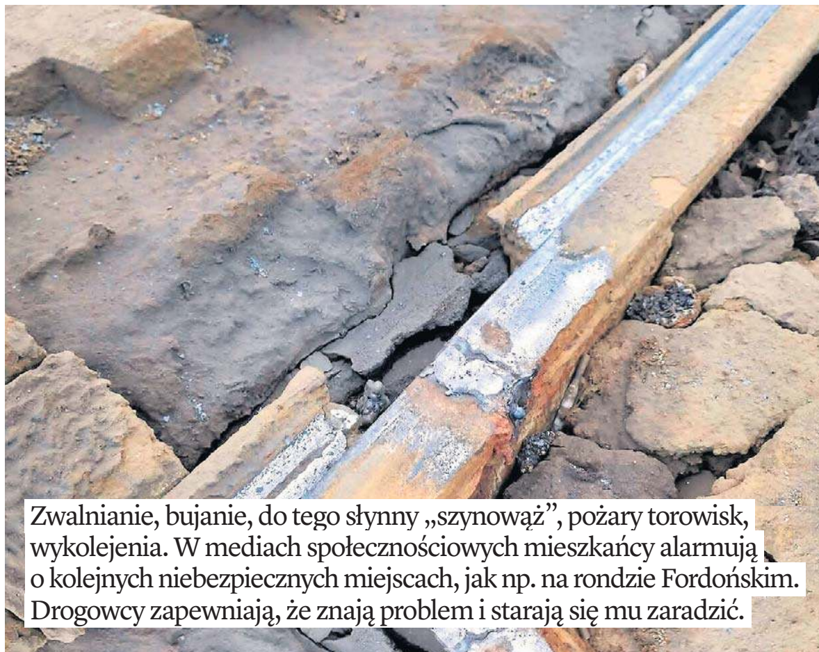
19 października 2025 r. pęknięcie szyny w ul. Focha
