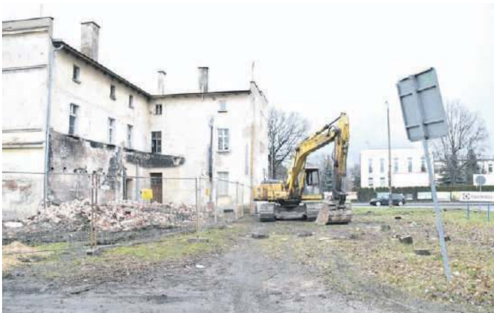
Pierwszy etap prac przy rozbiórce budynku rozpoczęto od tylnej części
