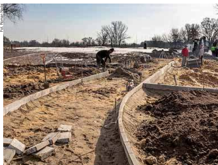
W sąsiedztwie parku wykonywane są miejsca parkingowe
