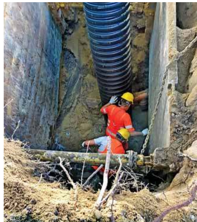
Budowa sieci kanalizacji sanitarnej
