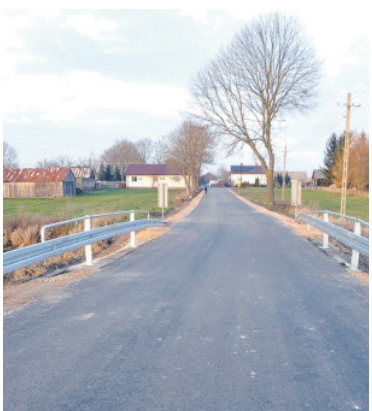
Droga w Kamiance po renowacji
