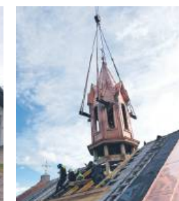
Remont wieżycy kościoła
