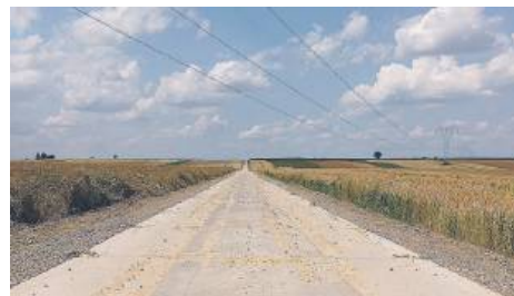
Droga Czysła Dębina-Kolonia, Baranica
