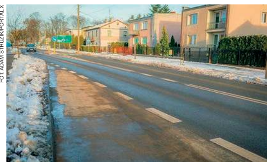
Remont drogi trwał ponad 3 lata
