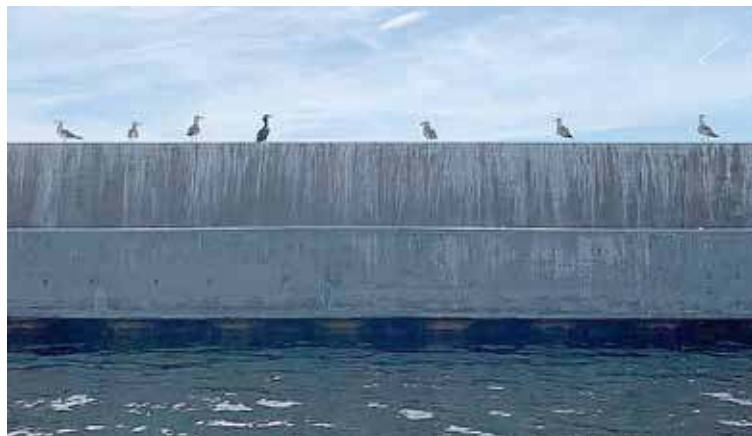
Budowa falochronu. Fot. Stepnica
