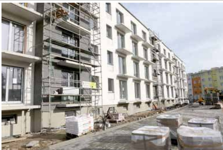
Budowa bloku pochłonie prawie 14 mln złotych
