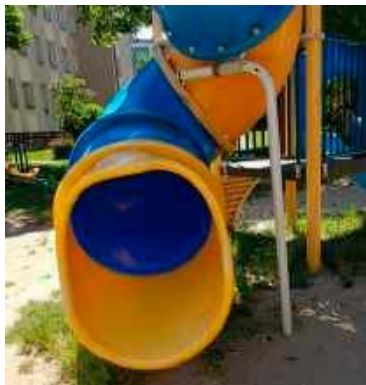
Urzednicy zapewniają, że wystające z ziemi, na wylocie ze zjeżdżalni, betonowe i metalowe elementy zostaną niezwłocznie zabezpieczone
