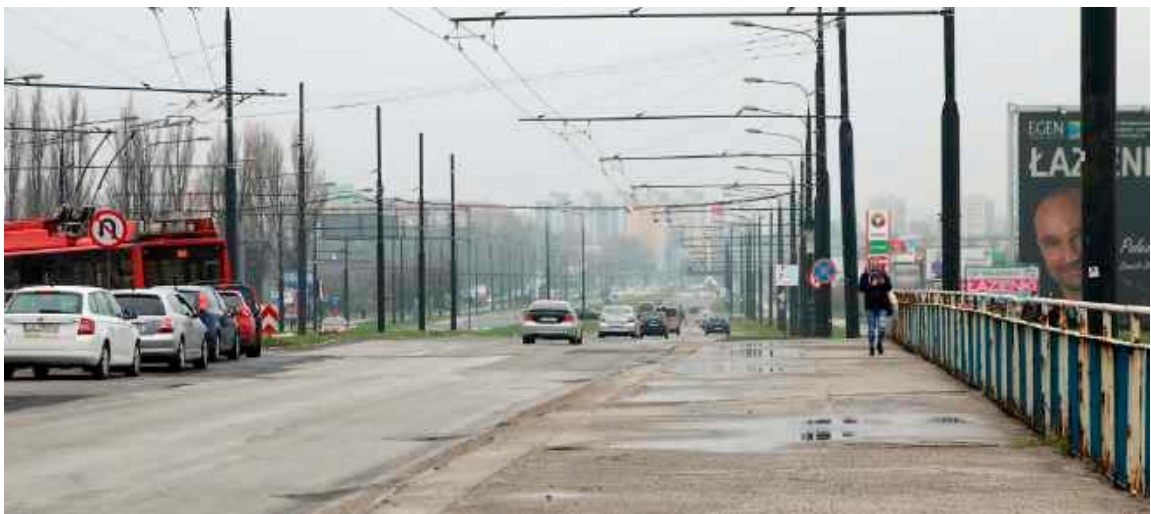
Aleję Unii Lubelskiej czeka gruntowna przebudowa, która obejmie również budowę nowych mostów
