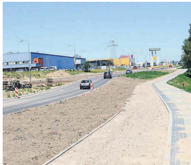
Skrzyżowanie al. JP II z ul. NSZ jest już gotowe w 70 proc. Prawie gotowe są już jezdnie, trwają prace przy chodnikach i ścieżkach rowerowych
