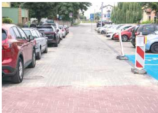
Nawierzchnia wykonana została w większości z kostki brukowej. Asfalt pojawia się bliżej skrzyżowania z ulicą Wyszynskiego
