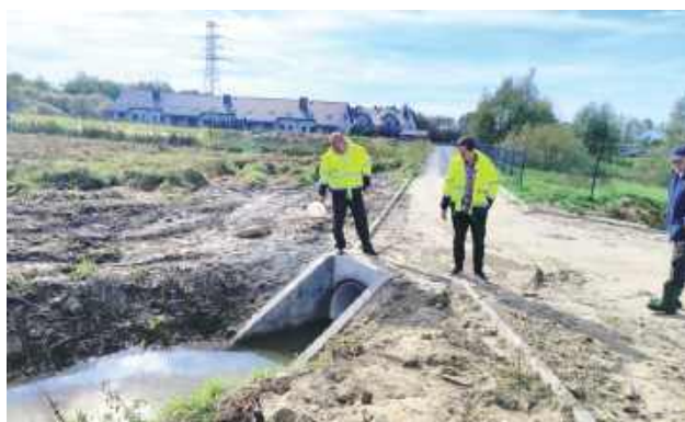
Przepust w miejscowości Kolonia Sól jest w okolicach zabudowy szeregowej
