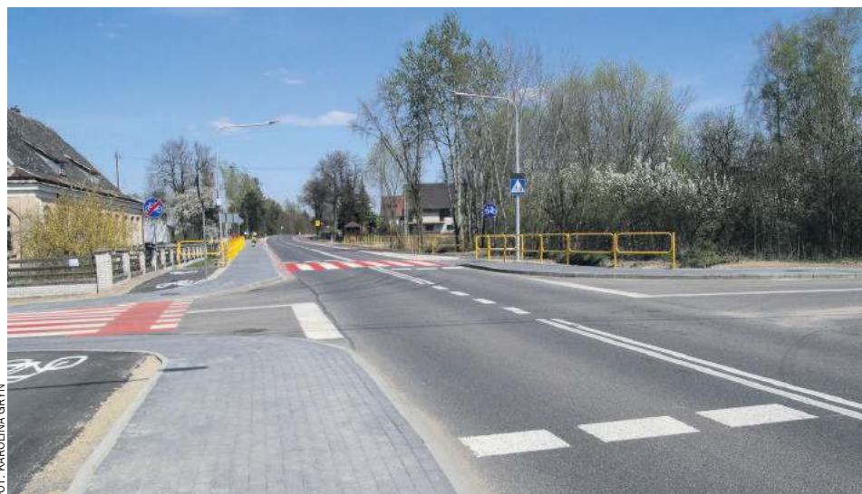
Dzięki przebudowie, wzmocnieniu i wykonanej infrastrukturze droga powiatowa nr 1069R powinna posłużyć podróżującym na lata
