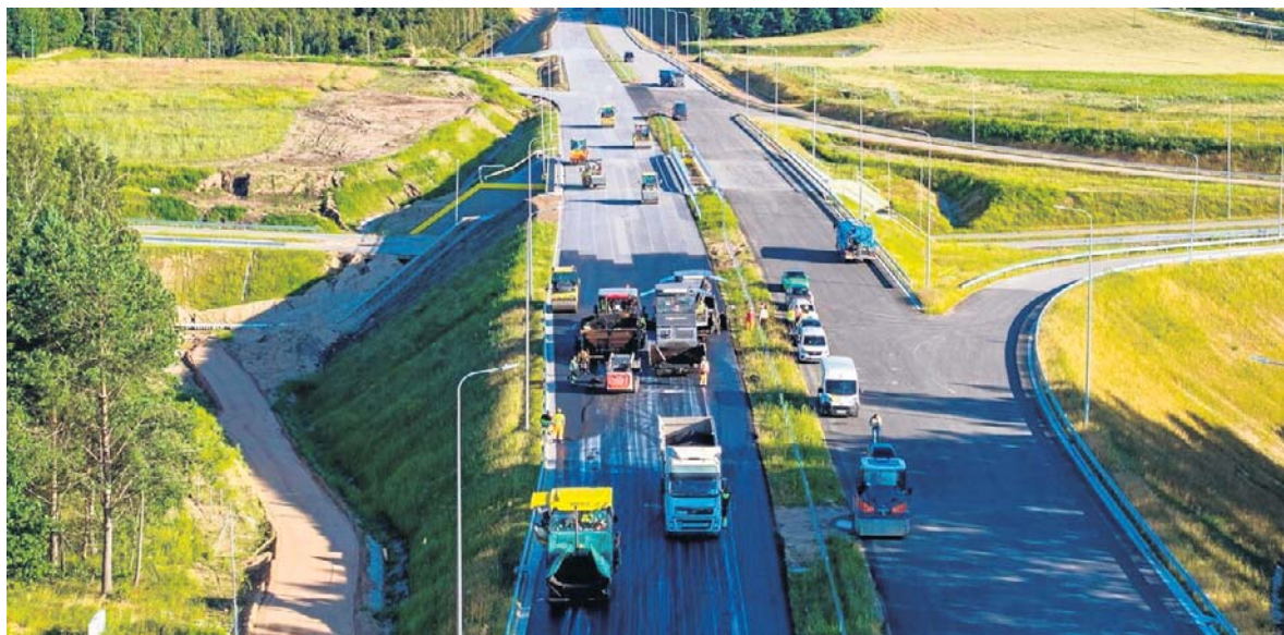
Jeszcze w tym roku odcinek drogi ekspresowej S11 z Bobolic do Szczecinka zostanie oddany do użytku
