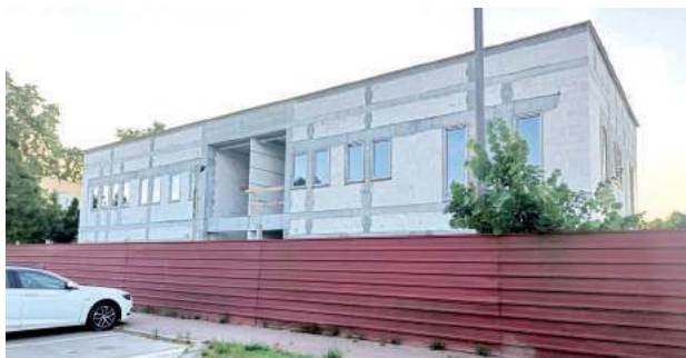
Nowa siedzibna ZUK-u na razie jest na etapie budowy. Jeśli wszystko pójdzie zgodnie z planem miejska spółka przeprowadzi się tu w połowie przyszłego roku
