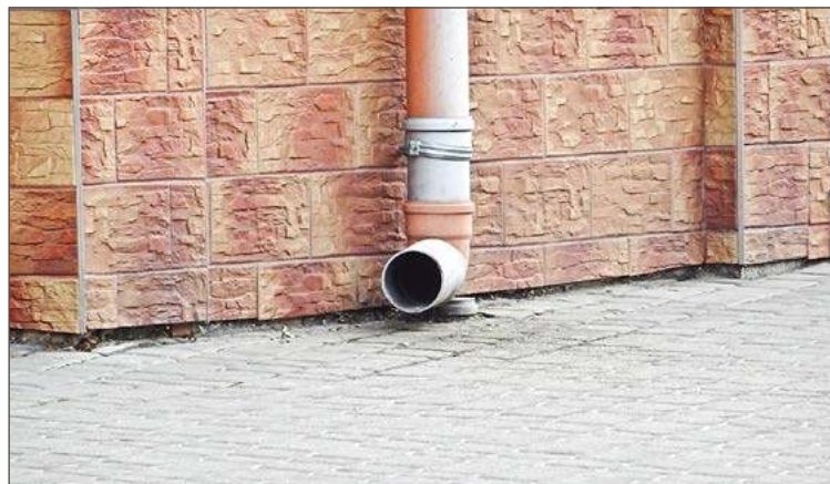
Woda opadowa z rynien, zamiast na chodnik, trafi do zbiornika.
