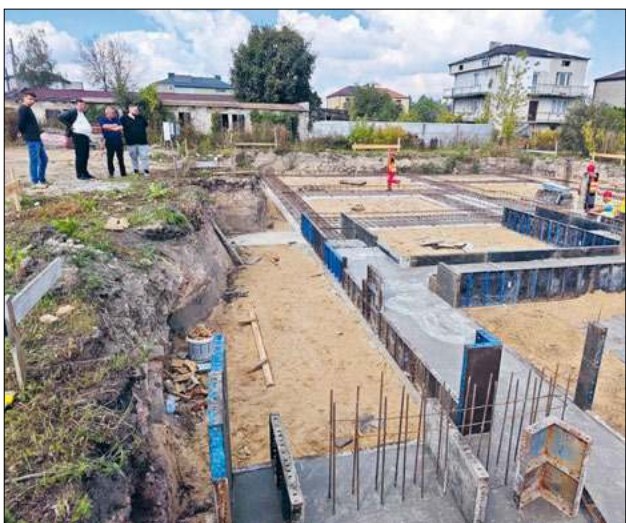
Trwa budowa bloku w ramach programu SIM, przed jej rozpoczęciem archeolodzy odkryli w tym miejscu fundamenty dawnego ratusza, który został rozebrany w XIX wieku
