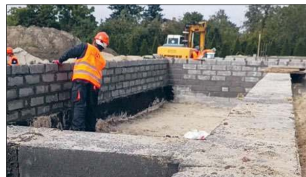
Na budowie trwają intensywne prace. Powstaną 24 nowe mieszkania
