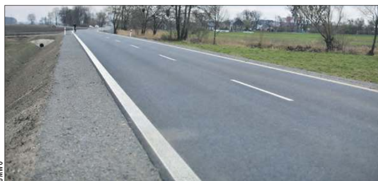
Odnowiony odcinek drogi
