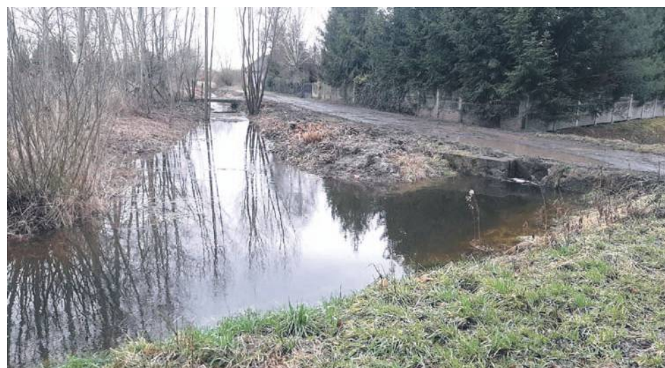
Poniemiecki przepust wypełniony
