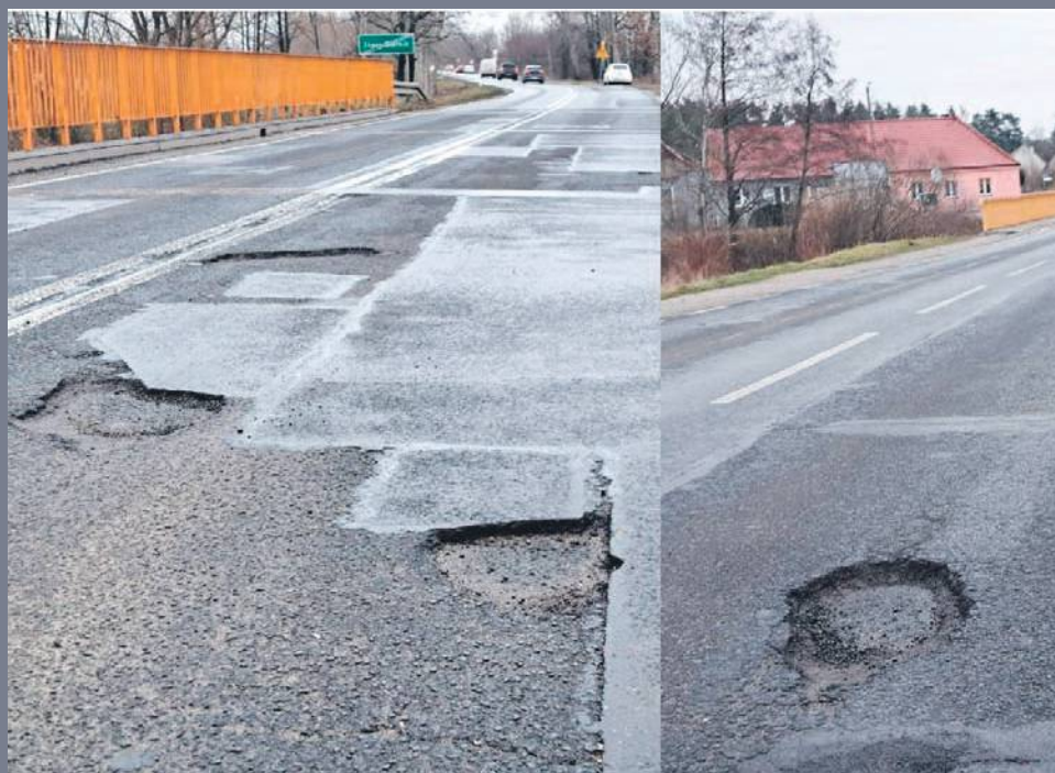
Sprawdziliśmy - akurat te dziury już naprawiono
