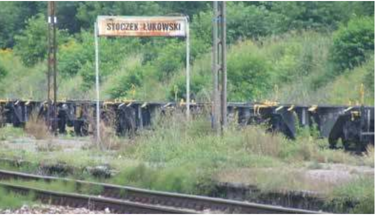
Stacja kolejowa w Stoczku Łukowskim wymaga kapitalnego remontu. Tu kiedyś był peron.
