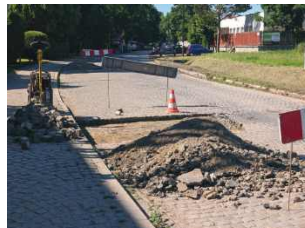
Trwa przekładanie granitowej kostki na ul. Długiej w Kondratowicach. Prace mają wyeliminować nierówności i uskoki nawierzchni
