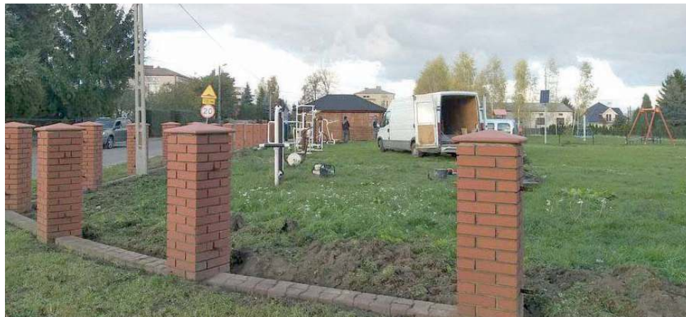
W ramach projektu zaplanowano wymianę podłoża i ułożenie nawierzchni z trawy rolowanej, zamontowanie bramek i piłkochwyty oraz remont ogrodzenia
