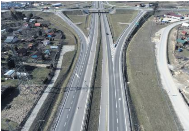
GDDKiA w Lublinie informuje, że prace przy budowie drugiej nitki obwodnicy Tomaszowa Lubelskiego są wykonane w 90 proc.
