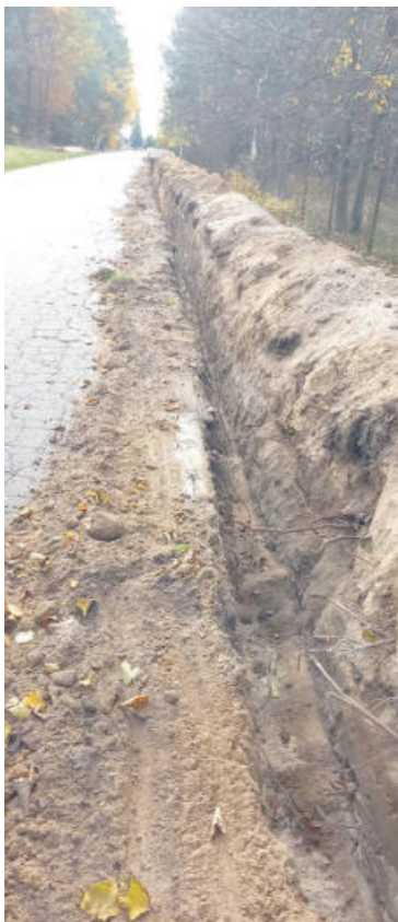
Wykopy przy drodze w Stasinie
