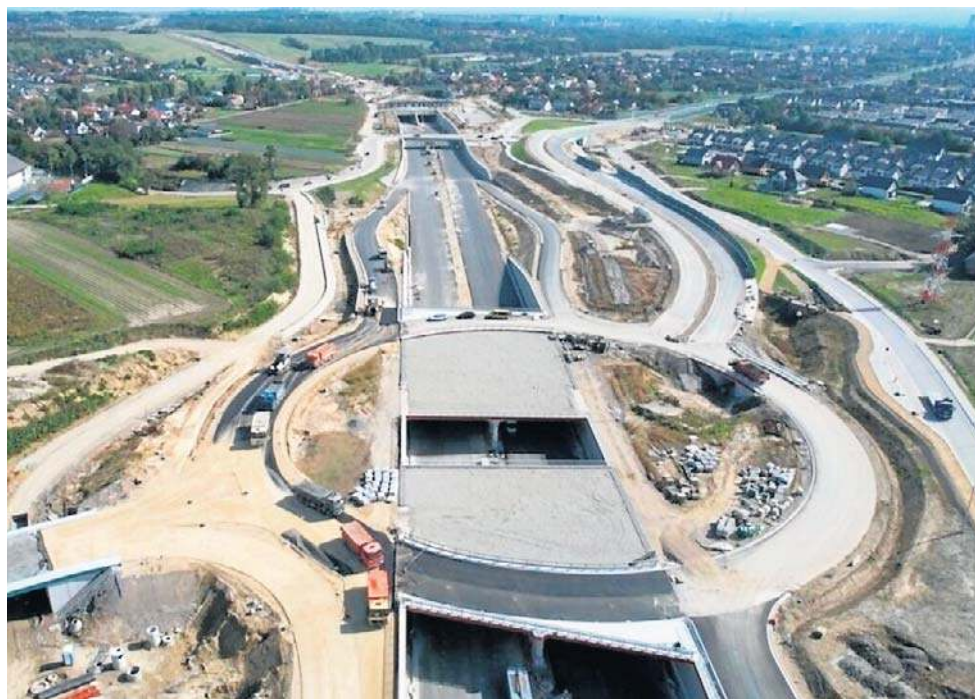
Budowa Północnej Obwodnicy Krakowa
