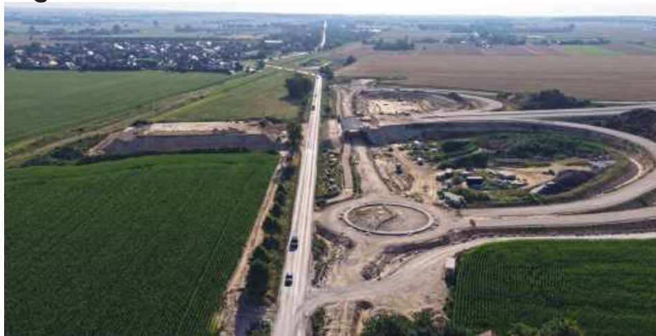
Widok na węzeł Zamość Północ. Fot. GDDKiA
