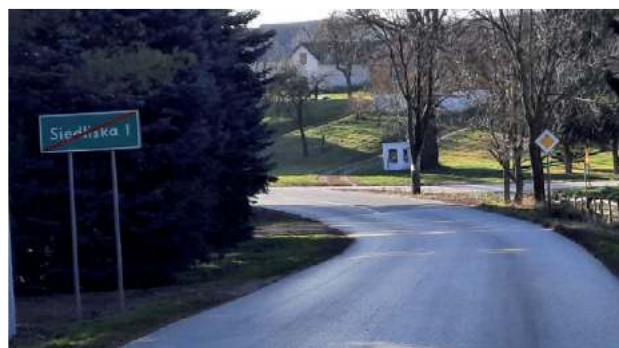
Przebudowa drogi powiatowej Suchodoly-Siedliska-Ksawerówka
