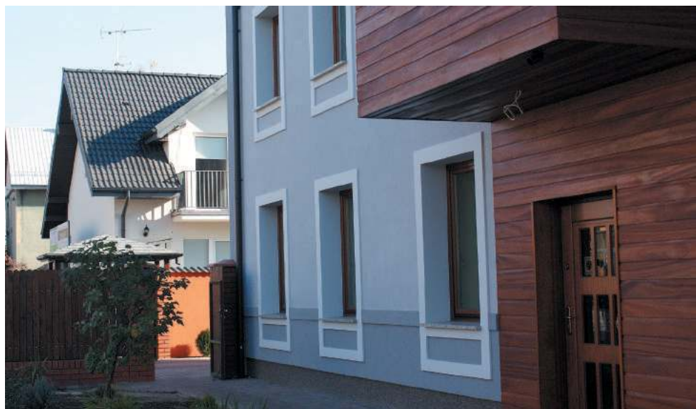
Obecny wygląd budynku przy ul. Słowackiego 5. Drzwi wejściowe zostały przesunięte dwie osie na prawo
