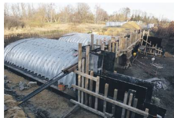
W ramach prac przebudowywany jest jeden z mostów na ul. Brzegowej. Fot. UMiG Strzelin
