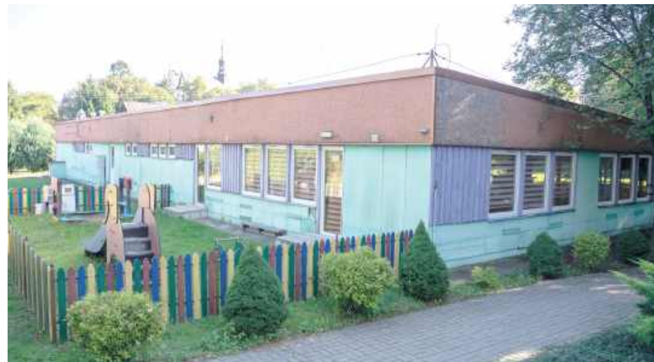
Przedszkole przed rozbiórką
