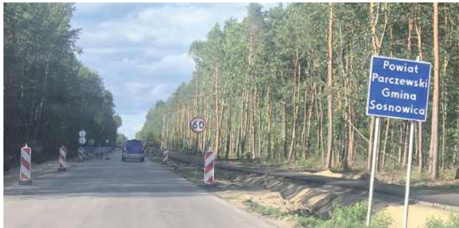
Nowy asfalt został ułożony m.in. na granicy powiatów parczewskiego i łęczyńskiego
